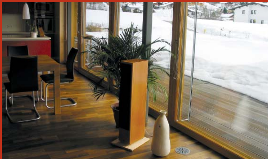
Obr. 1 O kvalitní vnitřní prostředí a neustálý přísun čerstvého vzduchu se stará větrací jednotka. Jediné co většinou z celého systému zůstane vidět jsou vyústky a nasávací ventily, které lze vhodně zakomponovat do interiéru.
