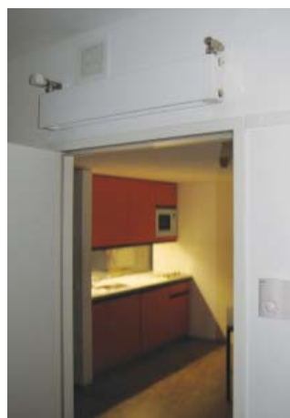
Obr. 7 Kombinace větrání a otopného zdroje v místě vyústky poskytuje dobrou regulovatelnost a nízké vstupní náklady.
