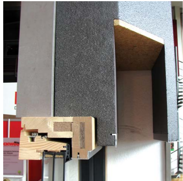
Obr. 9 Okna nové generace určená do energeticky úsporné výstavby jsou koncepčně nastavena tak, aby po správném zabudování (kompletně schovaná v izolaci) získala svůj vzhled podobný bezrámovému zasklení s optikou čistého skla. Nahore okno osazené správně do dřevostavby, dole detail se systémově řešeným žaluziovým kastlíkem.
