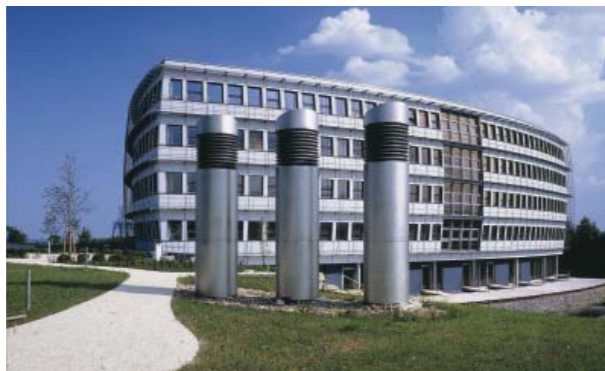
Obr. 8 Administrativní budova v Německu je ukázkou, že v pasivních standardech lze stavět i velké objekty. Přepracovaný systém topení a chlazení zde využívá geotermální energii z vrtů. Teplonosná látka proudí betonovými stropy, které slouží jako akumulátory tepla nebo chladu s postupným a rovnoměrným výdajem.
