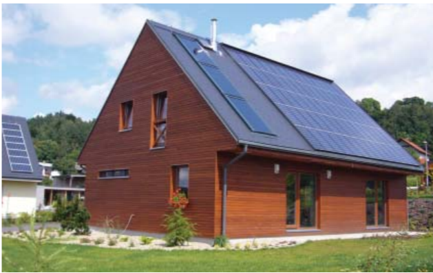
Obr. 5 Nulový dům aneb dům s nulovou potřebou energie. V podstatě jde o pasivní dům s větší plochou fotovoltaických článků, které v celoroční bilanci vyrovnávají potřebu energie. V případě přebytků odevzdávaných do sítě pak jde o dům plusový.
