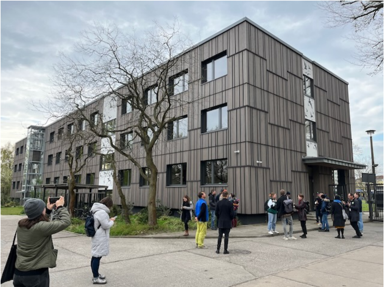
Obrázek 5 – Prefabrikovaný obvodový plášť administrativní budovy Berlínské ZOO, rekonstrukce panelového objektu z 60. let 20. století
