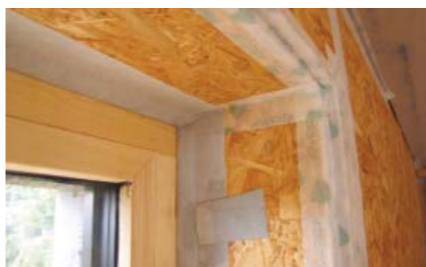
Obr. 12 Ochlazované místo v detailu napojení francouzského okna a podlahy způsobeno nesprávným napojením vzduchotěsné vrstvy. Při odhalování netěsností může být nápomocné i termovizní snímkování. (Foto Stanislav Paleček)
