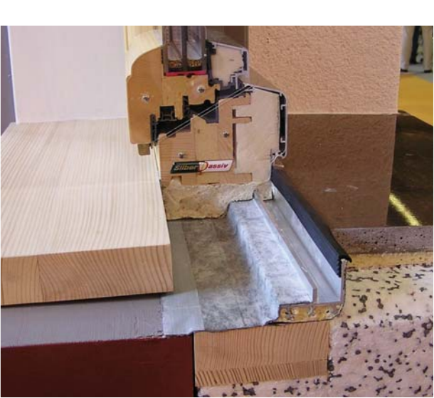
Obr. 9 Problematická místa při utěsnění oken a dveří lze řešit pomocí speciálních pásek a lišt vyvíjených pro tento účel. Nedostatečné utěsnění např. pouze PUR pěnou při instalaci oken bývá důvodem častých škod.
