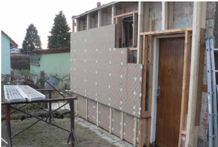
Obr. 3 Montáž dřevovláknitých desek jako podklad pro omítku.
