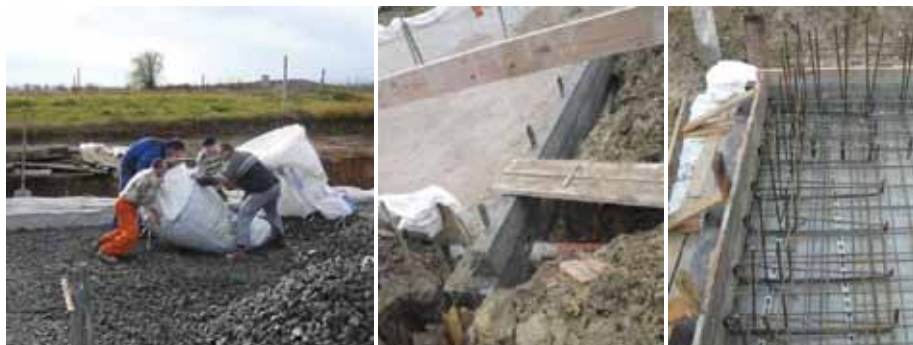
Obr. 3, 4, 5 Izolácia z penového skla, jej oporný múr a príprava betonáže základovej dosky.
