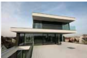
Obr. 7 Dřevěná nástavba s terasou
