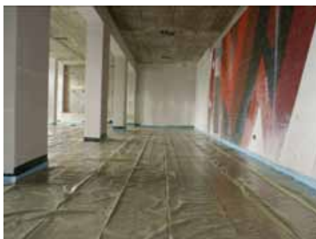
Obr. 7 Krycí separační podložka pod potěr
