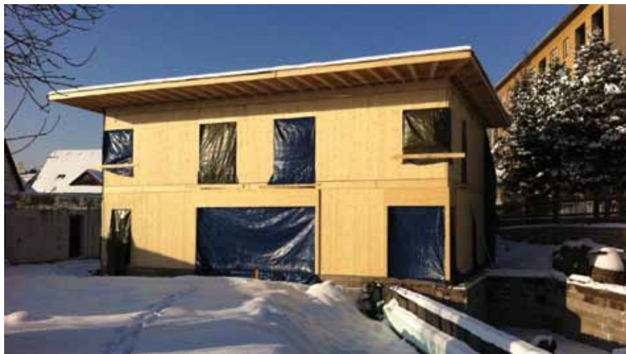
Obr. 5 Hrubá stavba z masivních dřevěných panelů (Vize Ateliér, s.r.o.)
