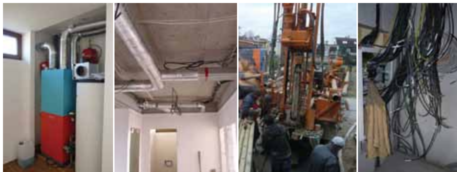
Obr. 19, 20, 21, 22 Kompaktná jednotka vo výklenku, rozvod vzt v podhlade, vrt, káble elektroinštalácie
