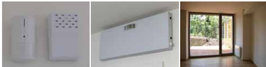
Obr. 18, 19, 20 Vyústka přívodu vzduchu do ložnice je integrovaná do sálavého panelu
