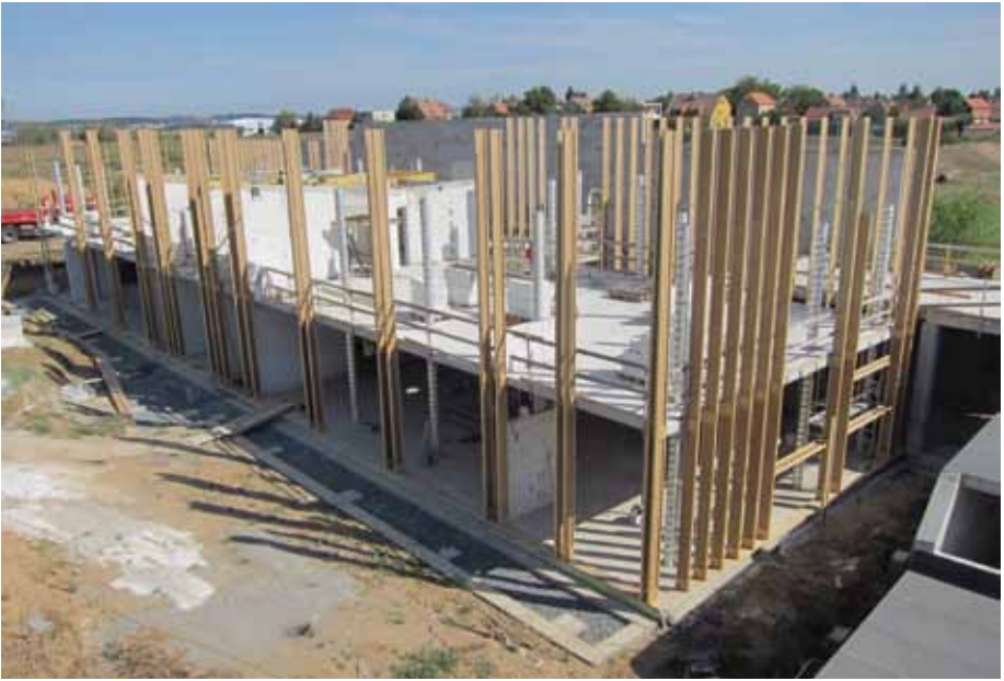
Obr. 9 Hotové monolitické a zděné konstrukce, probíhá montáž dřevěného pláště
