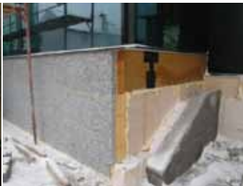
Obr. 11 Detail zateplení soklu
