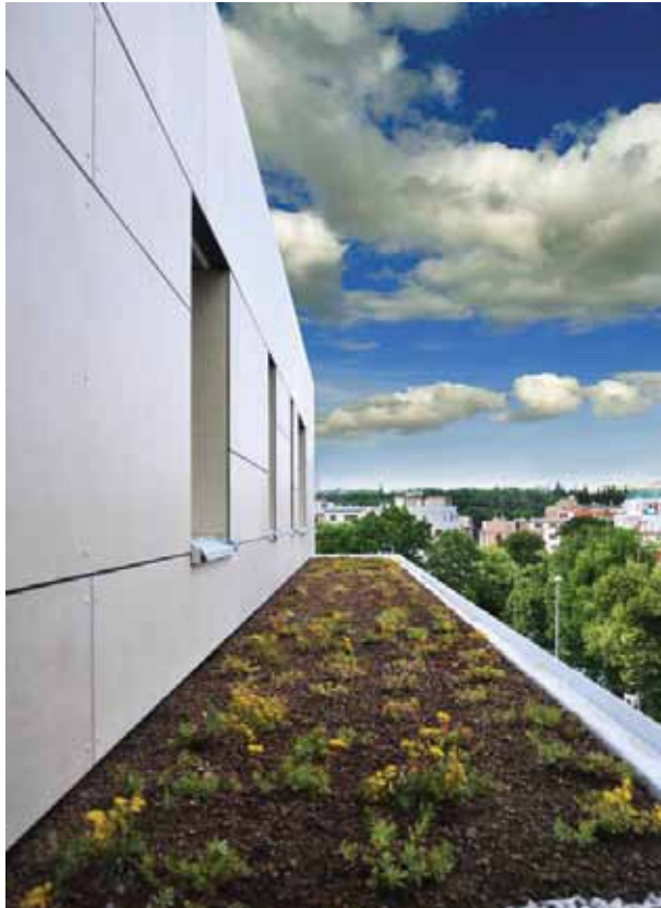
Obr. 14 Pohled na ustupující atiku 3. NP se zelenou střechou
