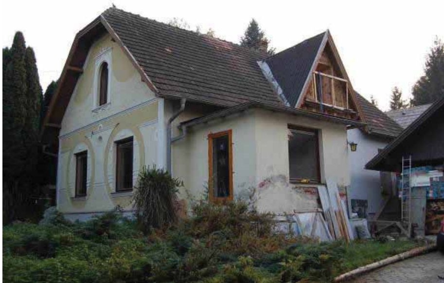
Abb. 1 Ansicht Ost mit noch ungedämmten Zubau Nord
