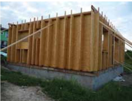
Abb. 5 Isolierständer – Zwischenraum ausgefüllt mit Wärmedämmung, Dicke 360 mm
