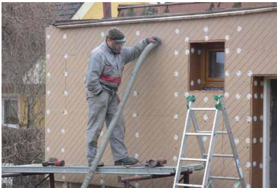
Obr. 4 Aplikace foukané celulózy do izolačního prostoru kapsy.
