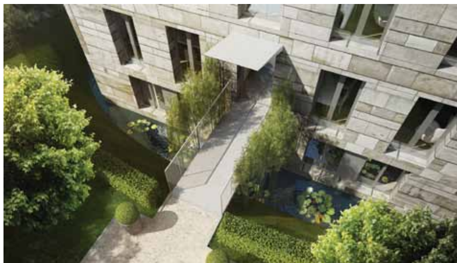
Obr. 7 Pohled na vstupní můstek s vodním prstencem
