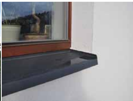
Obr. 6 Důsledná eliminace tepelných mostů – ostění zatepleno tepelnou izolací tl. 60 mm
