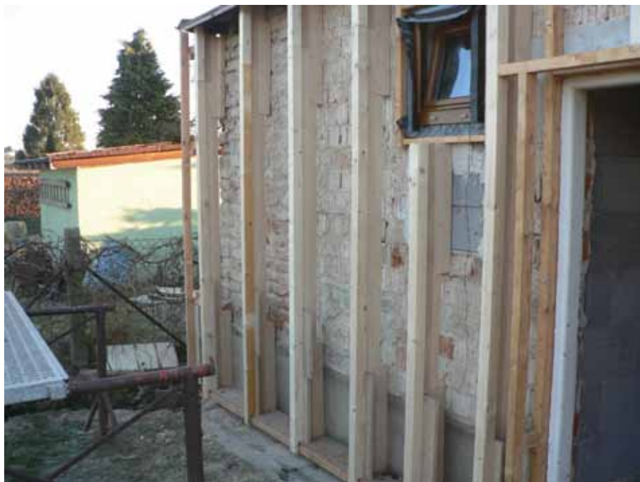
Obr. 2 Instalace expanderů na stávající fasádu včetně vyrovnání.
