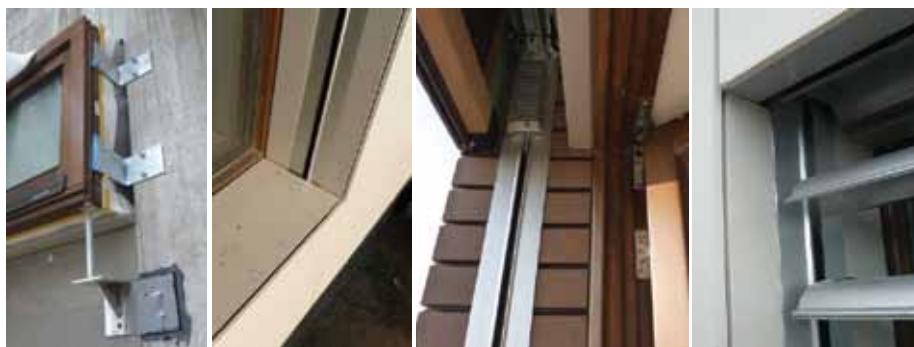
Obr. 12, 13, 14, 15 Montáž okna vysunutého pred stenu, parapet, žalúziový box, spustená žalúzia.
