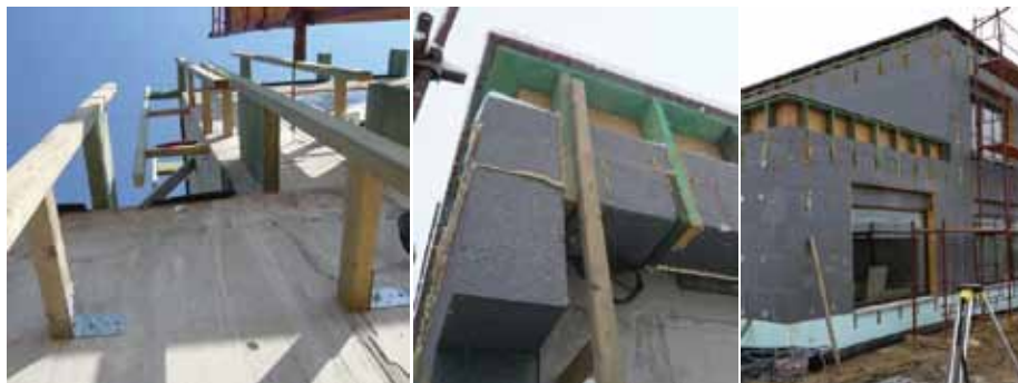
Obr. 9, 10, 11 Nosný rošt fasády, montáž izolácie stien okolo jeho prvkov, zaizolovaný dom.
