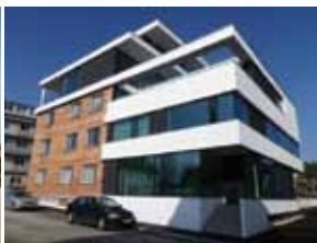
Obr. 8 Uliční fasáda před dokončením
