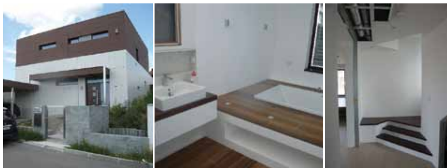
Obr. 16, 17, 18 Obklad fasád (veľkoplošný a „drevo“), riešenie kúpeľne, začiatok schodišťa
