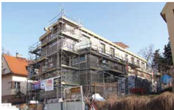
Obr. 8 Hrubá stavba s vnější stěrkou jako pojistkou pro zajištění plynutěsnosti těsně před aplikací tepelné izolace
