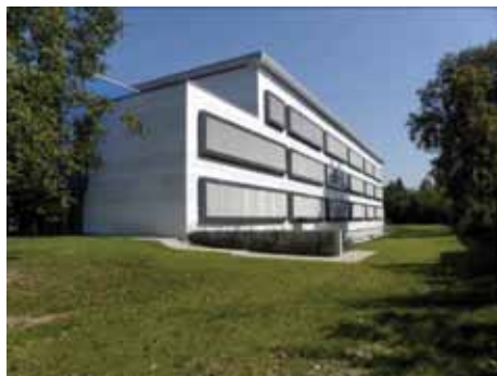
Obr. 3 Pohled z jihu
