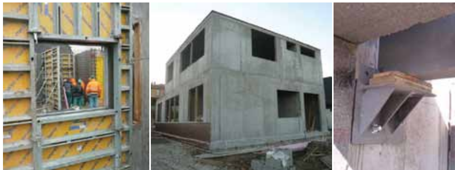
Obr. 6, 7, 8 Príprava systémového debnenia, hotová hrubá stavba, uloženie oceľových nosníkov.
