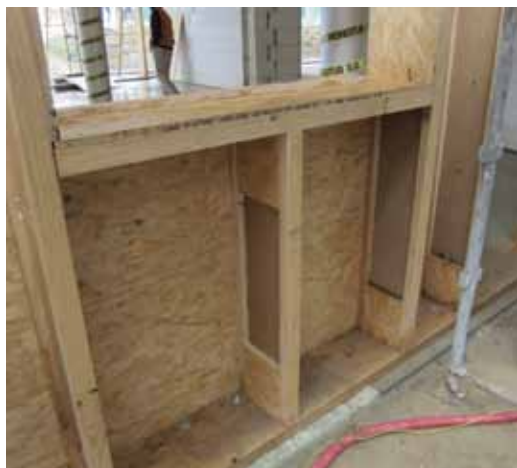
Obr. 11 Detail prahu dřevěné stěny – pro potlačení tepelného mostu v patě stěny jsou stěnové I-nosníky přesazeny přes žb základovou desku, pod prahem je XPS.
