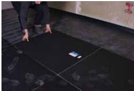
Abb. 1 Einfache und sichere Verlegung der VIPs auf dem ebenen Untergrund
