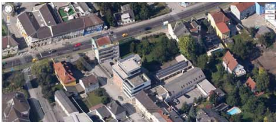
Obr. 18 Celkový pohled na uliční zástavbu a objekt při přestavbě
