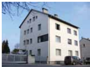
Obr. 1 Dům před přestavbou
