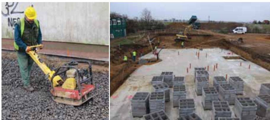
Obr. 4, 5 Hutnění pěnoskla, základová deska mateřské školy
