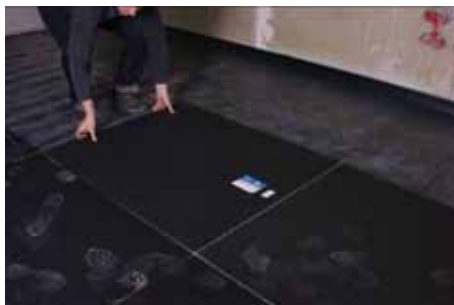
Obr. 1 Jednoduché a bezpečné pokládání VIP na rovném podkladu
