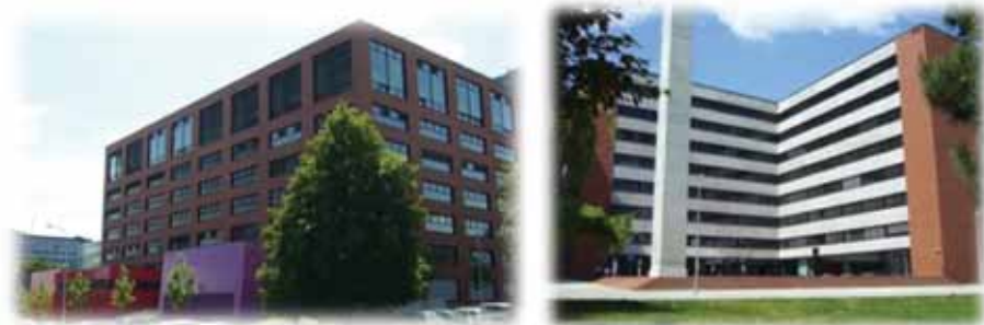
Obr. 1 Nová budova ČVUT- severní pohled vlevo a jižní pohled vpravo (3)
