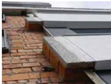
Obr. 9 Detail zateplení fasády
