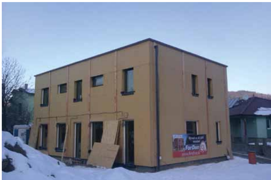
Obr. 2 Ecocube Max v Starej Kremničke, štádium hrubej stavby
