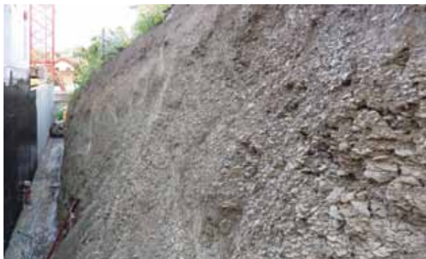
Obr. 6 Využitelnost celé šíře parcely na 90 % umožnily ideální základací podmínky na zvětralé břidlici a pohodlně bylo možné provádět i veškeré podzemní izolace a rozvody ve velmi příkrém výkopu
