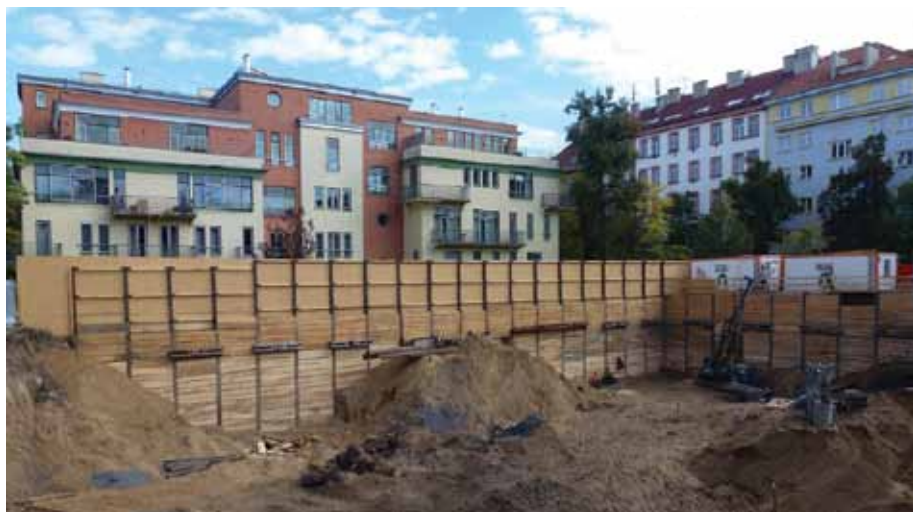
Obr.9 Provádění výkopových prací, září 2012
