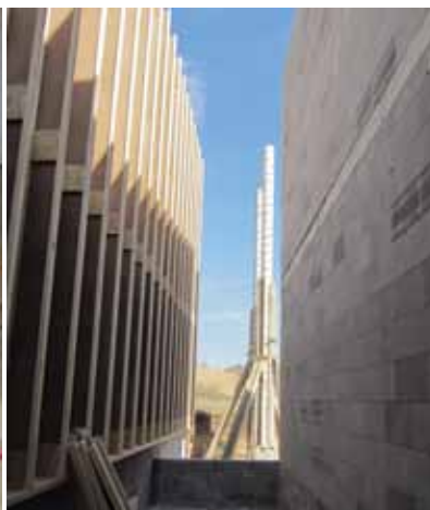
Obr. 12 V levé části dřevěný plášť MŠ, kotvený v patě a v úrovni stropu do žb desek, krov je vynášen monolitickým skeletem uvnitř dispozice. V pravé části plynosilikátová stěna přístupové chodby a zároveň budoucí tělocvična.
