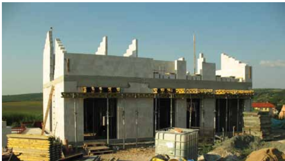
Obr. 3 Hrubá stavba z vápenopískových tvárníc (Vize Ateliér, s.r.o.)
