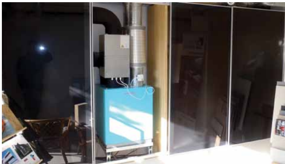
Obr. 4 Jednotka aerosilent® umístěna do vestavných skříní (Dny pasivních domů 2011)
