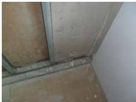
Obr. 4 Otvory směrem do konstrukce po demontáži staré příčky
