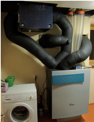
Větrací jednotka s rekuperací tepla včetně zemního výměníku. Alternativy ke kovovým rozvodům mohou být textilní nebo dřevěné rozvody.
