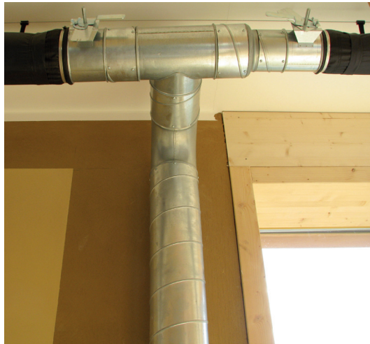
Větrací jednotka s rekuperací tepla včetně zemního výměníku. Alternativy ke kovovým rozvodům mohou být textilní nebo dřevěné rozvody.
