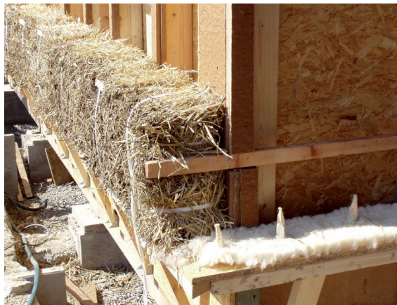
Slaměné balíky jsou přivazovány k dřevěné konstrukci, prostor za nimi je vyfoukán celulóou.
