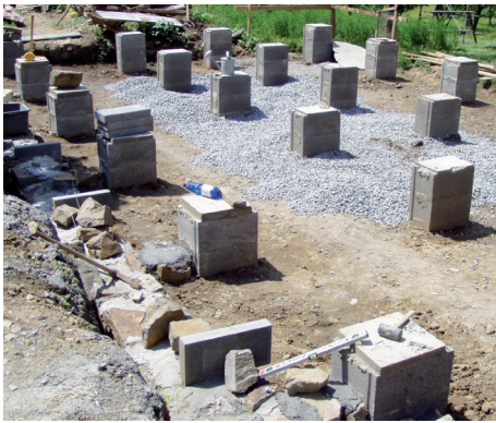
Základové patky jsou úspornější variantou pasových základů a betonové desky. Na nich stojí roznášecí modřínový práh a dřevěné l-nosníky zavěšené proti klopení, které tvoří rošt pro izolaci.
