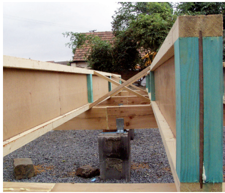
Základové patky jsou úspornější variantou pasových základů a betonové desky. Na nich stojí roznášecí modřínový práh a dřevěné l-nosníky zavěšené proti klopení, které tvoří rošt pro izolaci.
