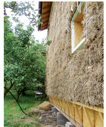
Slaměné balíky jsou přivazovány k dřevěné konstrukci, prostor za nimi je vyfoukán celulóou.
