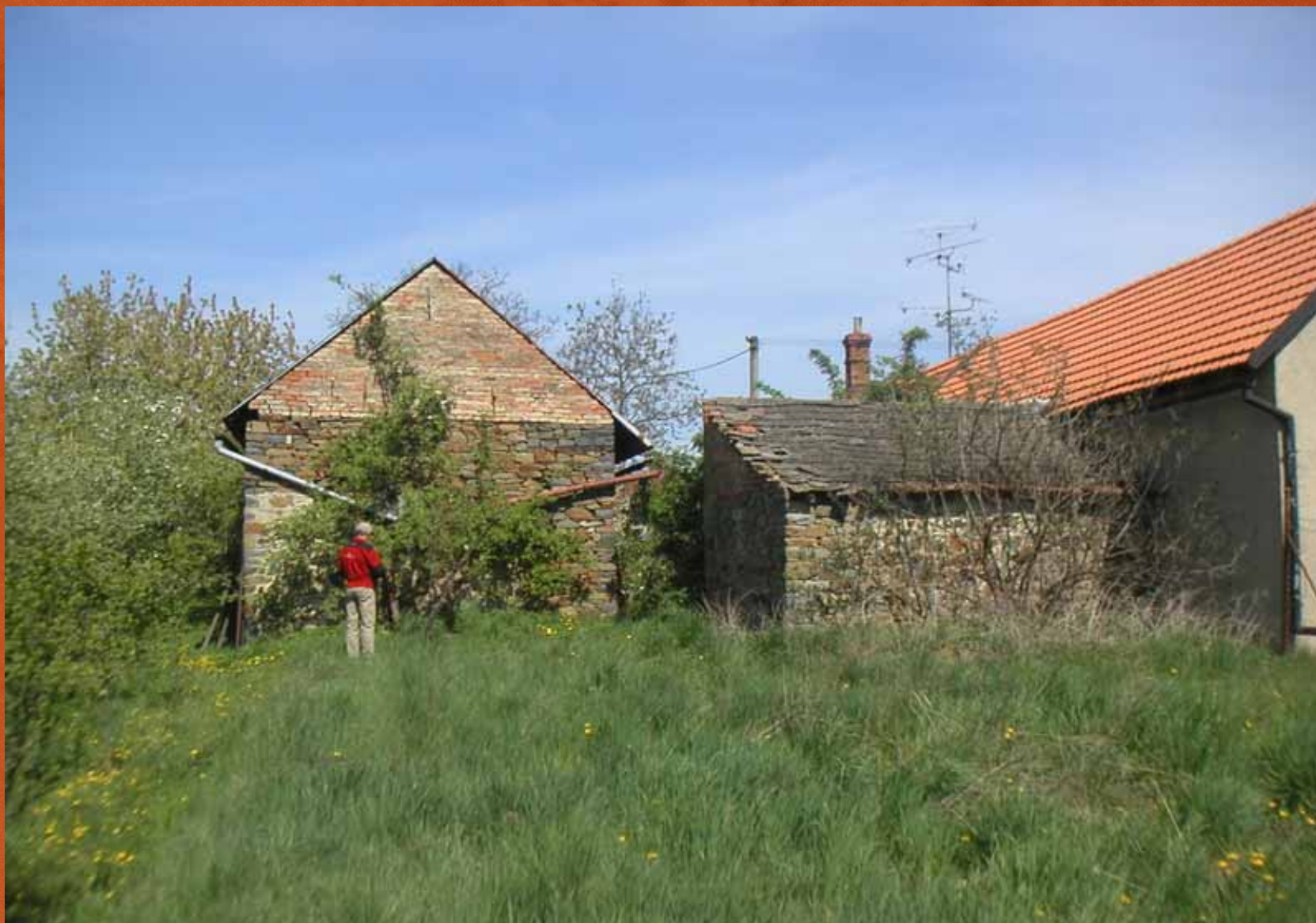
Původní stav a sousední dům z JV
