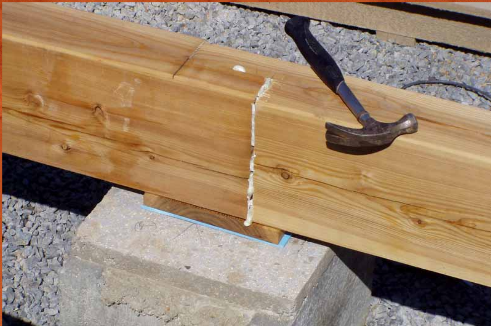
dubové podložky pod trámy
