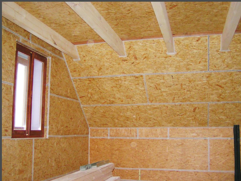
Neprůvzdušnost zajíštuje spojité vzduchotěsnící vrstva, která musí být precizně vyhotovena. Veškeré napojení konstrukcí a stavební otvory jsou utěsněny speciálními páskami. Kromě tepelných ztrát tato vrstva chrání konstrukce před vlivem vlhkosti, která se šíří přes netěsnosti.
