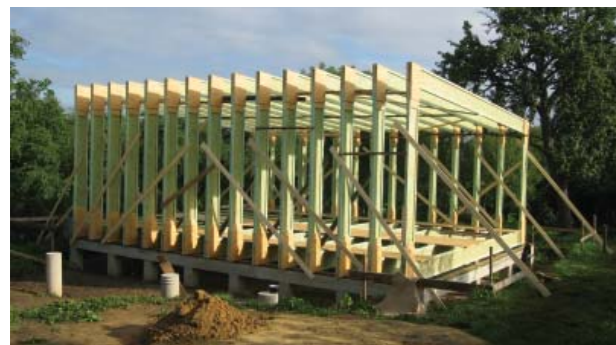
Obr. 7 Příklad dřevostavby s použitím I nosníků. Konstrukce je zevnitř zavětrována OSB deskou a izolace je vkládána do připraveného roštu. Výhodou je jednoduchost a rychlost provedení. (Zdroj Mojímí Hudec)
