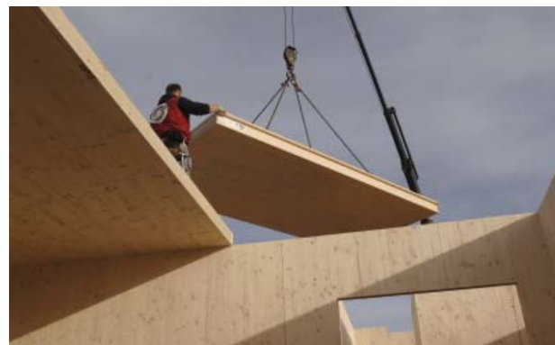
Obr. 6 Prefabrikace šetří čas na stavbě a poskytuje vynikající přesnost. Masivní dřevěné prvky zároveň při malé tloušťce stěny zajišťují potřebnou únosnost a v pohledové kvalitě mohou šetřit další vrstvy. (Zdroj NOVATOP)
