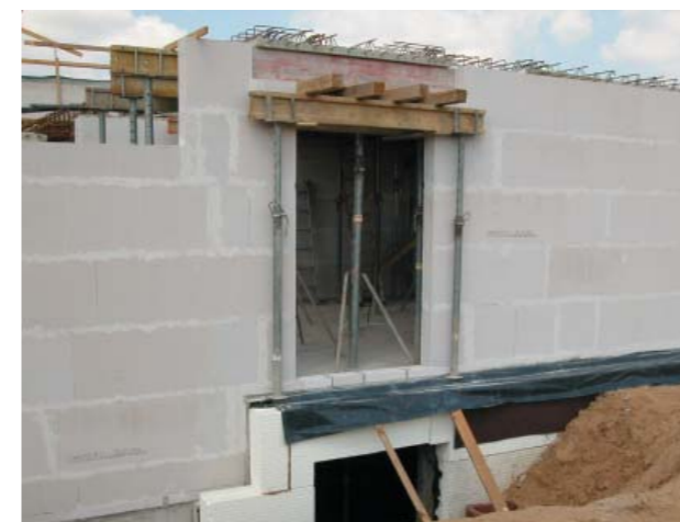
Obr. 8 Masivní konstrukce z vápenopískových cihel je pro pasivní domy ideální. Velká objemová hmotnost zabezpečuje vysokou únosnost, výborné akustické vlastnosti a akumulaci schopnost při malé tloušťce stěn. Současně jde o materiál s velmi nízkou spotřebou primární energie při výrobě. Větší vápenopískové bloky umožňují rychlé mechanizované zdění pomocí minijeřábů. Zateplení se pak realizuje běžnými kontaktními systémy.
