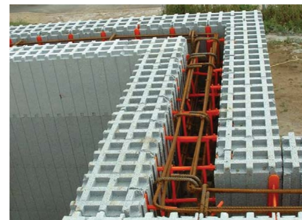
Obr. 9 Systémy ztraceného bednění lze také využít pro stavbu pasivních domů. Systémy zpravidla obsahují tvarovky pro rohy, překlady nebo i základy, což značně urychluje výstavbu. (Zdroj Asting)
