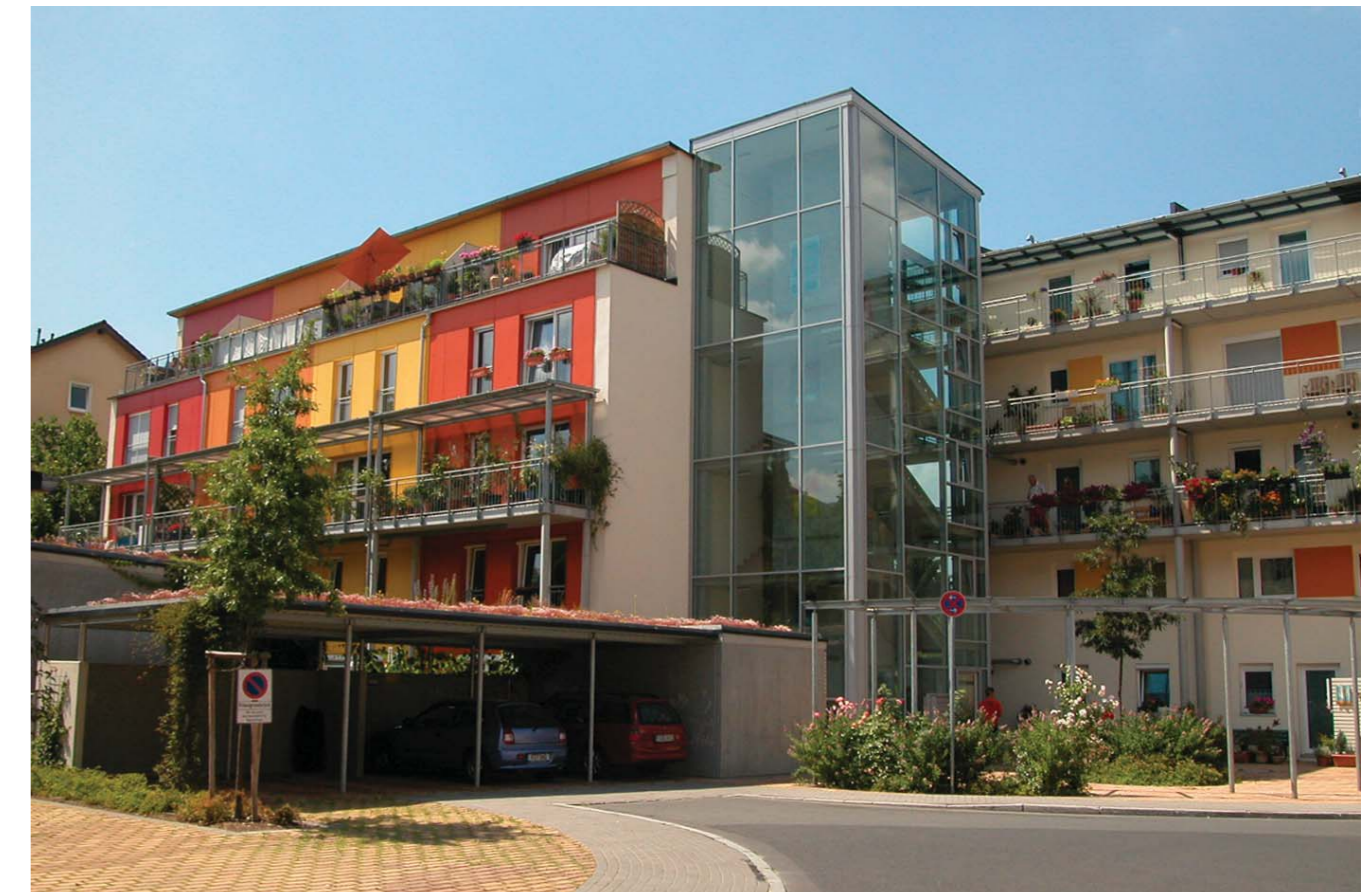
Obr. 1 Větší objekty jako bytové domy jsou díky výhodnému poměru ochlazované plochy k vnitřnímu objemu pro dosažení pasivního standardu ideální.
