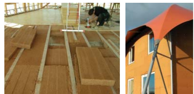
Obr. 7 Izolace z přírodních materiálů mají obdobné využití jako běžné izolace – vkládané do roštu nebo jako fasádní izolace s tenkovrstvým omítkovým systémem. (Foto A. Brotánek)
