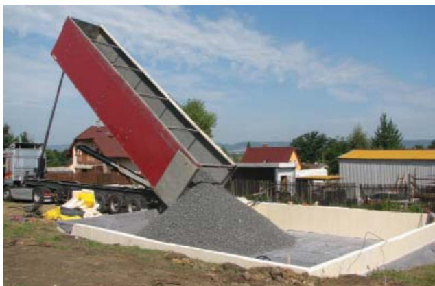
Obr. 12 Šterk z pěnového skla je často používán při zakládání betonové desky na izolaci. Na ztuhněnou vrstvu pěnoskla se následně provede armovaná železobetonová deska. (Foto: Kalksandstein)
