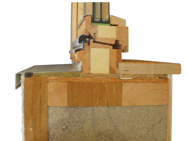
Obr. 8 Příklad osazení okna do parapetu (nahore) a simulace teplotních polí v místě ostění (vlevo). Jak je vidět, okno je vyloženo co nejvíce do exteriéru v kastlíku z OSB desek, aby se snížilo na minimum stínění ostěním. Rám okna je vyplněn polyuretanovou izolací a překryt zvenku tepelnou izolací.
