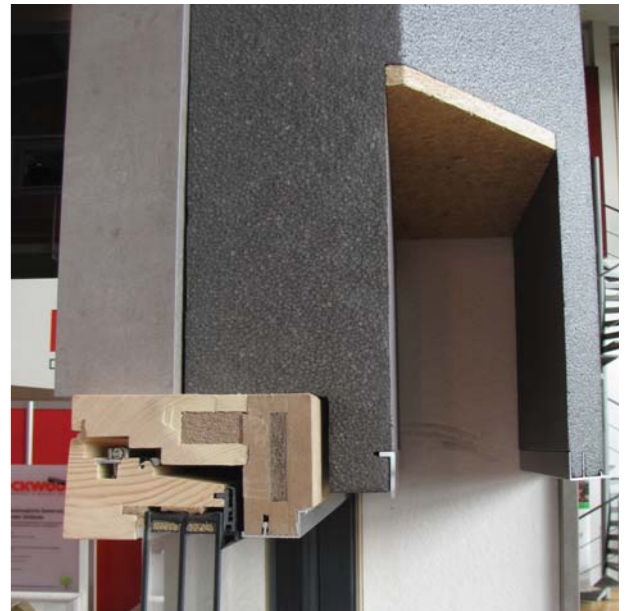
Obr. 9 Okna nové generace určená do energeticky úsporné výstavby jsou koncepčně nastavena tak, aby po správném zabudování (kompletně schovaná v izolaci) získala svůj vzhled podobný bezrámovému zasklení s optikou čistého skla. Nahore okno osazené správně do dřevostavby, dole detail se systémově řešeným žaluziovým kastlíkem.
