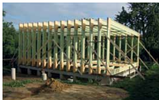
Příklad dřevostavby s použitím I nosníků.
