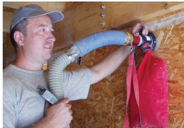
Obr. 6 Celulóza se nejčastěji aplikuje volným foukáním nebo pod tlakem do uzavřených dutin. Výhodou je cena a rychlost aplikace.
