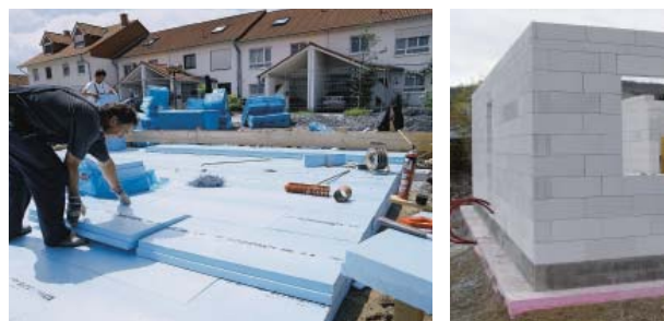
Obr. 11 Díky vysoké únosnosti a nenasákavosti je extrudovaný polystyren ideální pro použití například při založení betonové desky na izolaci. Tím je eliminován tepelný most v patě zdi a tepelná izolace probíhá kolem domu bez přerušení. (Foto DOW Europe, CPD)
