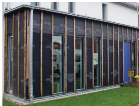
Obr. 2 Provětrávaná fasáda u novostavby před namontováním fasádního obkladu. Svislé laťování před pojistnou hydroizolací tvoří vzduchovou mezeru.
