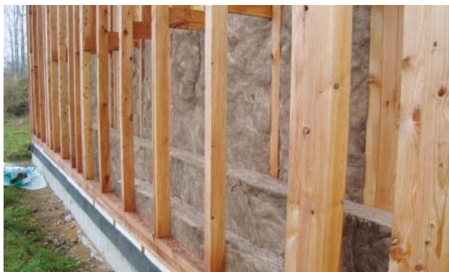
Obr. 4 Příklad vrstvené izolace do dřevěného roštu. Použity jsou nosníky, které neprochází skrze celou konstrukci, a tudíž nevytváří tepelné mosty. (Foto KNAUF Insulation)
