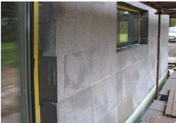
Obr. 5 Při montáži ETICS na bázi EPS lze na soudržný a rovný povrch do výšky 8 m celoplošně lepit bez kotvení. Na obrázku 30 cm EPS s přídavkem grafitu vápenopískové cihly. (Foto Kalksandstein)
