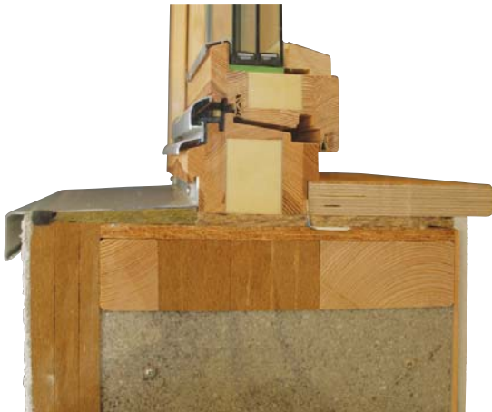
Obr. 8 Příklad osazení okna do parapetu (nahore) a simulace teplotních polí v místě ostění (vlevo). Jak je vidět, okno je vyloženo co nejvíce do exteriéru v kastlíku z OSB desek, aby se snížilo na minimum stínění ostěním. Rám okna je vyplněn polyuretanovou izolací a překryt zvenku tepelnou izolací.
