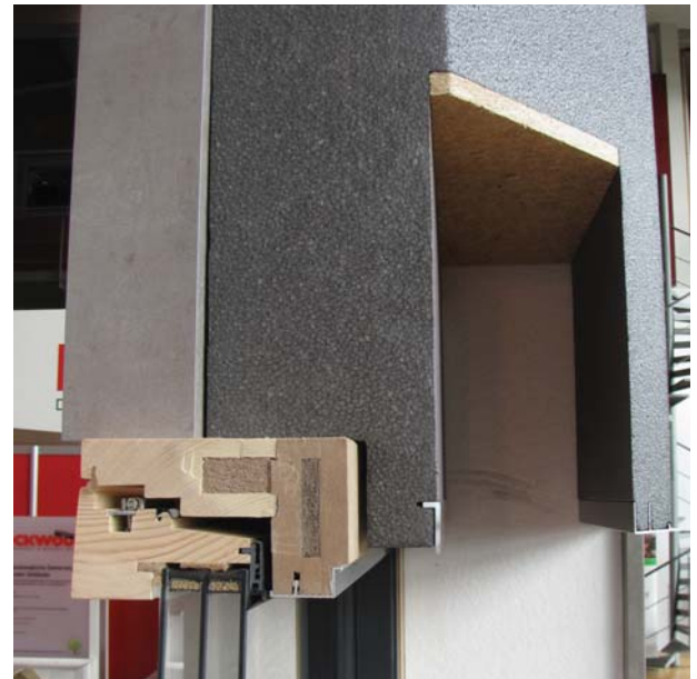
Obr. 9 Okna nové generace určená do energeticky úsporné výstavby jsou koncepčně nastavena tak, aby po správném zabudování (kompletně schovaná v izolaci) získala svůj vzhled podobný bezrámovému zasklení s optikou čistého skla. Nahoře okno osazené správně do dřevostavby, dole detail se systémově řešeným žaluziovým kastlíkem.
