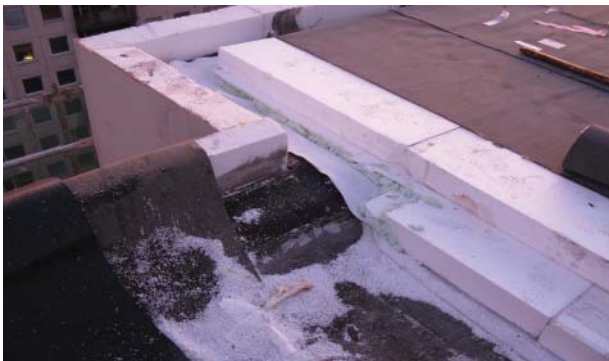
Obr. 8 U jednoplášťových střeš se jednoduše přidává izolace (nejčastěji EPS) v potřebné tloušťce, na které se následně provede hydroizolační vrstva. Jako ochranu hydroizolace v případě pochozích střeš lze použít betonový potěr, dlažbu nebo zásyp kačirkem. Také atiku je kvůli značným tepelným vazbám nutné zaizolovat po celém obvodu. (Zdroj Jana Drápalová, Brno, Nový Lískovec)
