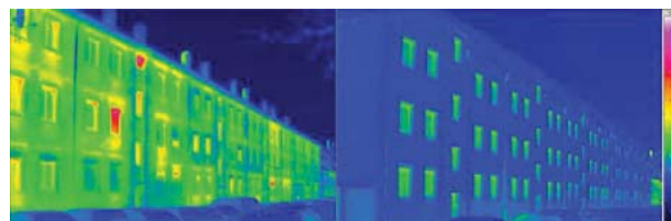
Obr. 10 Projekt Tevesstrasse ve Frankfurtu (Německo) před a po rekonstrukci, doplněno o termovizní snímek, kde je pěkně vidět rozdíl v kvalitě obálky. Roční spotřeba energie na vytápění 290 kWh/(m 2 a) před a 17 kWh/(m 2 a) po renovaci na pasivní standard. Úspora energie činí 95 %. (Zdroj Faktor 10)
