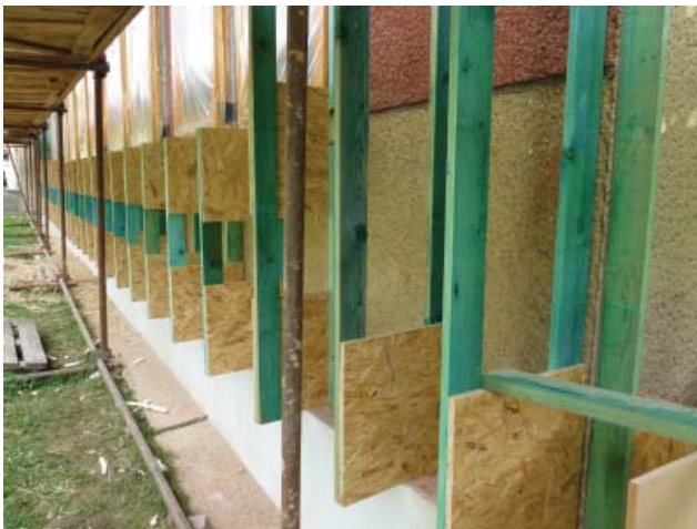
Obr. 4 Měkčí izolace jako minerální vlna, přírodní vláknité izolace nebo foukaná celulóza se umísťují do předsazeného roštu z dřevěných žebříkových nosníků nebo I-nosníků. Další vrstvy, např. rošt odvětrávané fasády nebo fasádní desky pro omítku, je možné do těchto prvků kotvit bez vzniku tepelných mostů. (Foto Mojmir Hudec)
