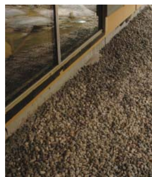
Obr. 7 Další možností, jak izolovat základy i podlahy, je použití granulátu z drceného pěnového skla. Tento materiál je nenasákavý a umožňuje dílůzi vodních par. Na dosažení hodnoty U = 0,15 \text{ W}/(\text{m}^2\text{K}) je potřebné izolovat podlahu vrstvou asi 50 cm štěrku z pěnového skla. (Zdroj Glapor)
